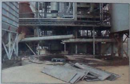
Estado en el que quedó la zona afectada. / EVA SÁNCHEZ
